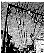
折れた電柱は千葉県館山市
